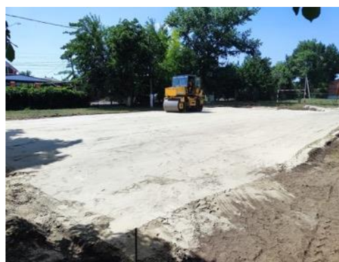
Устройство песчаного основания под фундаменты
