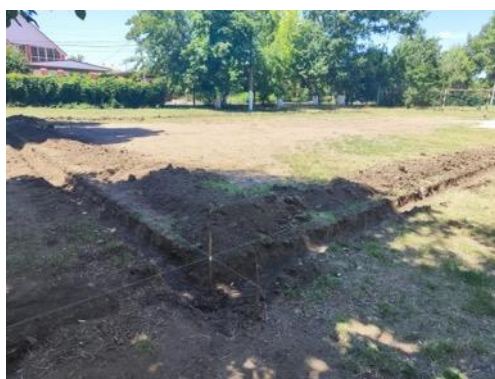
Разборка покрытий и оснований
