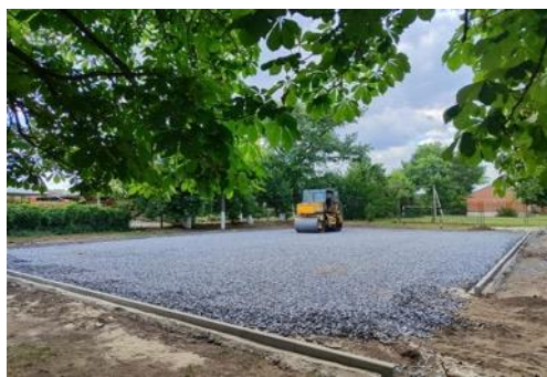
Устройство бортовых камней бетонных и оснований из известнякового щебня
