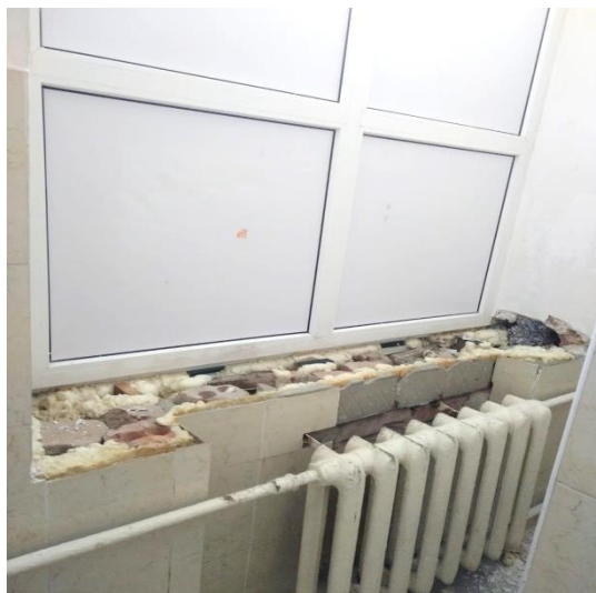
Корпус «Г». Устройство пола из керамической плитки, ремонт части кровли.
